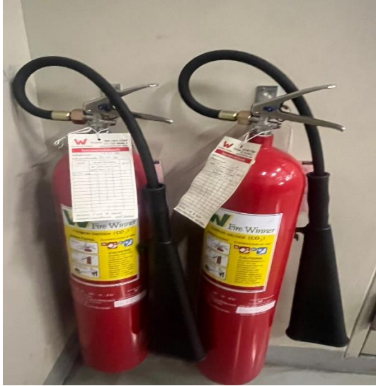
ภาพที่ 30 เครื่องดับเพลิงแบบมือถือ
