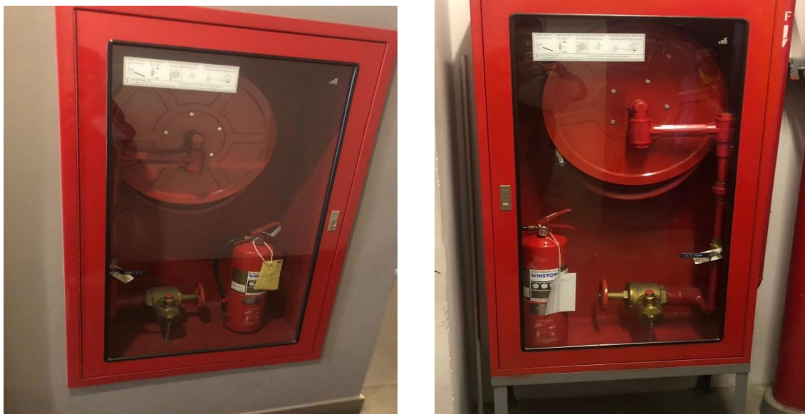
ภาพที่ 27 ตู้สายฉีดน้ำดับเพลิง
